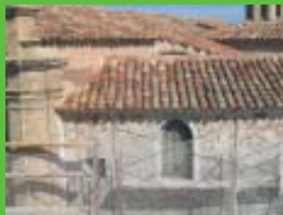
Fachada de la casa parroquial de la iglesia de Novallas, en restauración.
